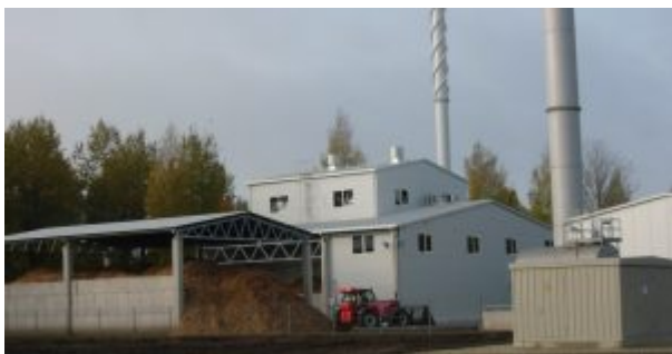
UAB „Akmenės energija“ katilinė Naujojoje Akmenėje
