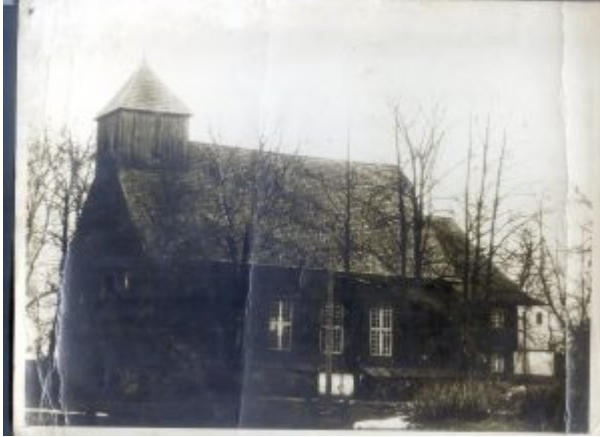
Karo sunaikinta Vegerių bažnyčia
